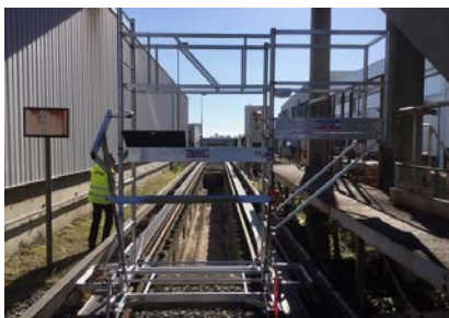
Réalisation pour la société de transports RTM (13)
