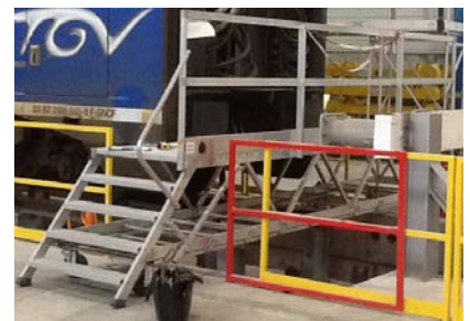
Réalisation pour la société Alstom Transport (90)
