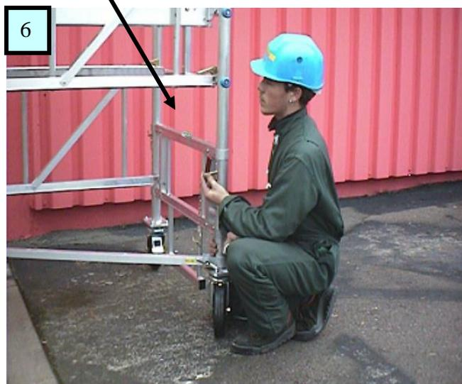
• Mettre à niveau les échelles et la structure à l 'aide des pieds réglables (fig. 5 et 6 )
