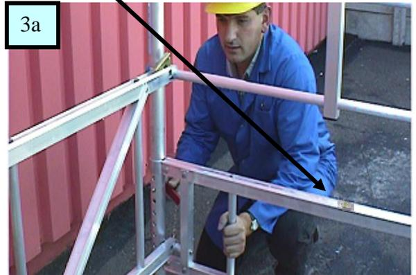
• Mettre à niveau les échelles et la structure à l'aide des pieds réglables (fig. 3 et 3a )
