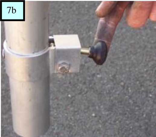
Positionner le 1er plateau dans l'axe de l'escalier d'accès ( fig. 7 ) Emboîter les cadres ( fig 7a ) puis contrôler le verrouillage ( fig.7b ) Installer les garde corps et continuer le montage( fig 7c ) Mettre en place les diagonales en les inversant de sens de chaque coté
