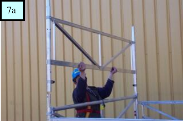
Positionner le 1er plateau dans l'axe de l'escalier d'accès ( fig. 7 ) Emboîter les cadres ( fig 7a ) puis contrôler le verrouillage ( fig.7b ) Installer les garde corps et continuer le montage( fig 7c ) Mettre en place les diagonales en les inversant de sens de chaque coté
