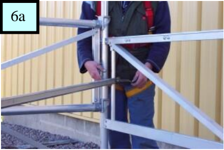
Mettre en place les diagonales horizontales RDPA et les verrouiller ( fig.6 et 6a )
