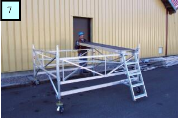
Positionner le 1er plateau dans l'axe de l'escalier d'accès ( fig. 7 ) Emboîter les cadres ( fig 7a ) puis contrôler le verrouillage ( fig.7b ) Installer les garde corps et continuer le montage( fig 7c ) Mettre en place les diagonales en les inversant de sens de chaque coté
