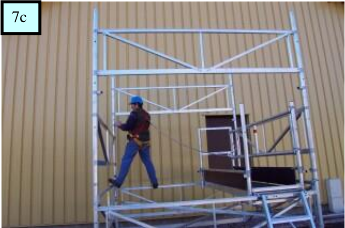
Positionner le 1er plateau dans l'axe de l'escalier d'accès ( fig. 7 ) Emboîter les cadres ( fig 7a ) puis contrôler le verrouillage ( fig.7b ) Installer les garde corps et continuer le montage( fig 7c ) Mettre en place les diagonales en les inversant de sens de chaque coté
